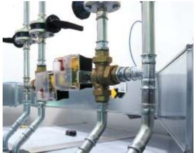
Рис. 22. steelPRES — контур охлаждения.
